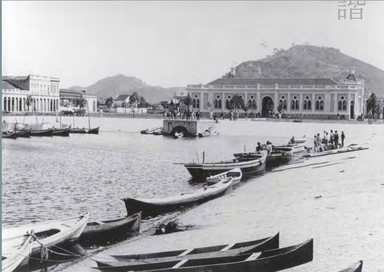
Rampa do Mercado – Na manhã de primavera chegadas e partidas...
